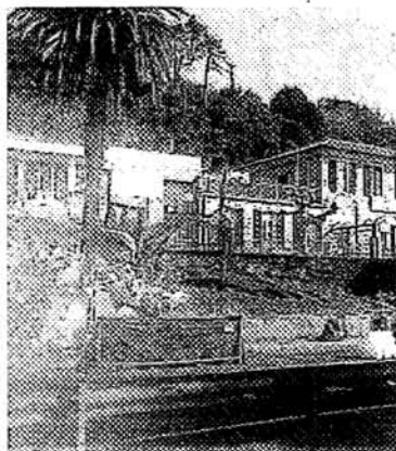
Partiti i lavori di ripristino della scarpata che divide la via Aurelia dall'inizio di via Antica Romana
